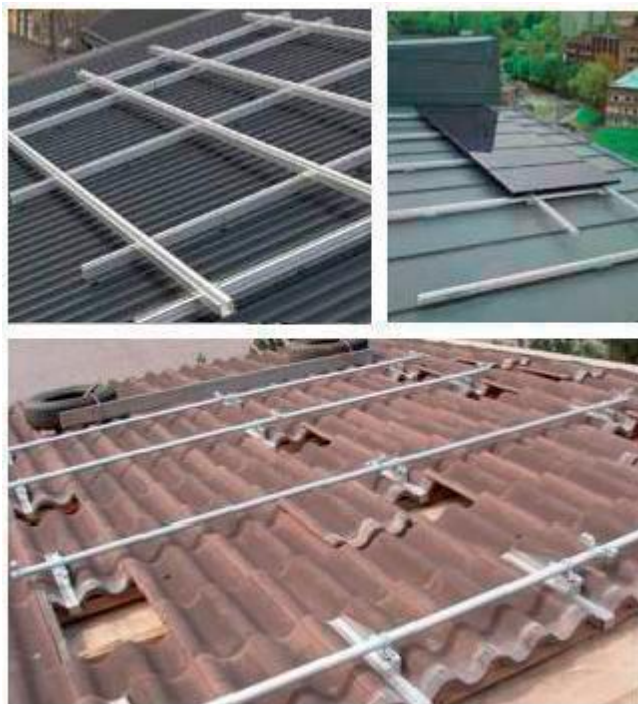
Kuva 7. Asennuskiskot kiinnitettynä erilaisiin kattomateriaaleihin. (Kuvat: Naps Systems Oy, Jyrki Jussila)
